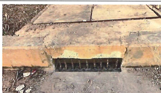
ภาพที่ 15 ตะแกรงดักขยะในรางระบายน้ำฝน
