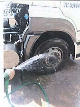
ภาพที่ 11 การทำความสะอาดล้อรถบรรทุก
