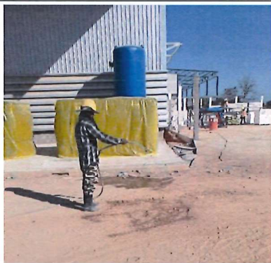
ภาพที่ 2 การฉีดพรมน้ำพื้นที่ก่อสร้างของโครงการ
